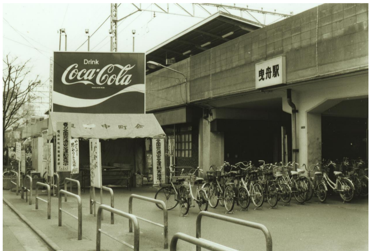
東武曳舟駅西口※22
