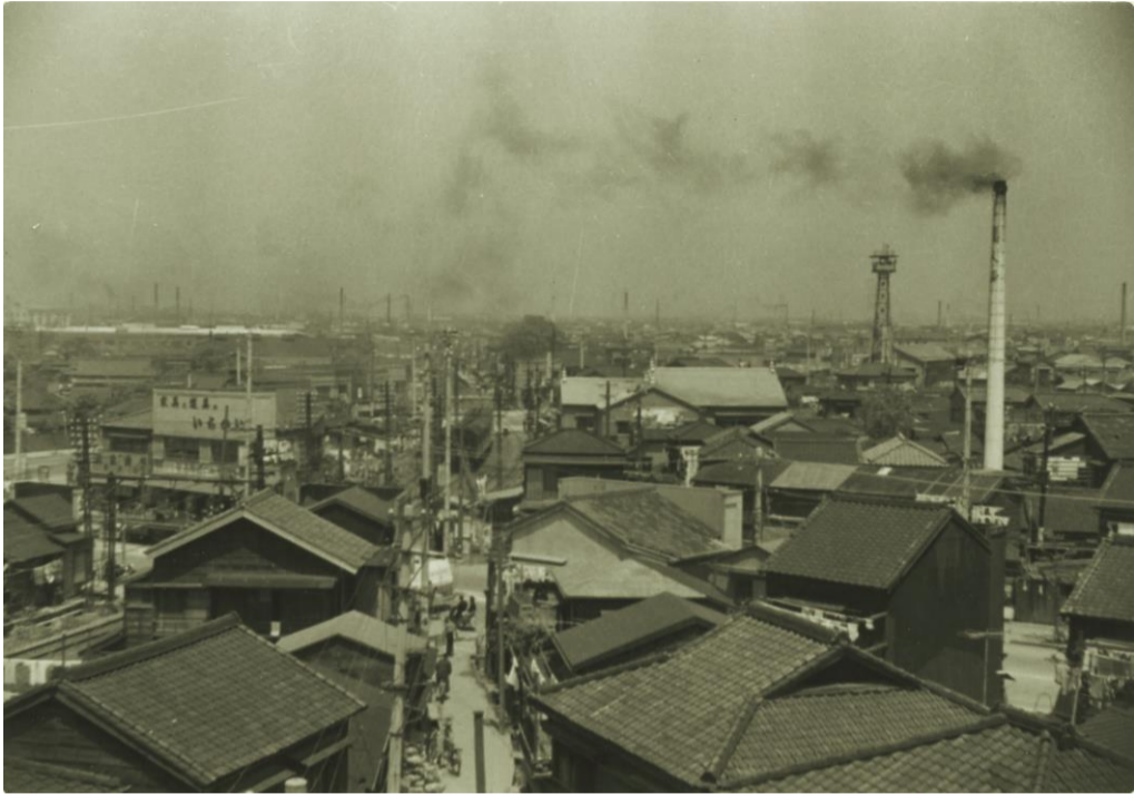
第2庁舎屋上から北方向※1
