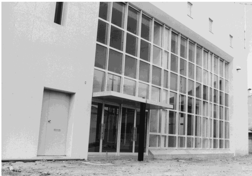
東向島会館(東向島公会堂:別館)※11
