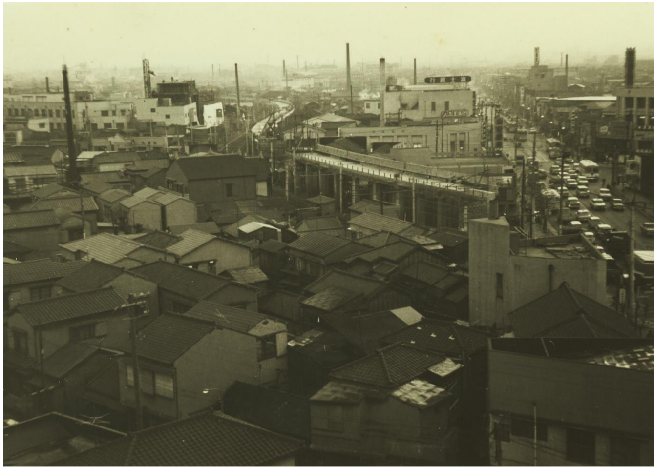
東武高架工事 曳舟～東向島(玉ノ井)※4
