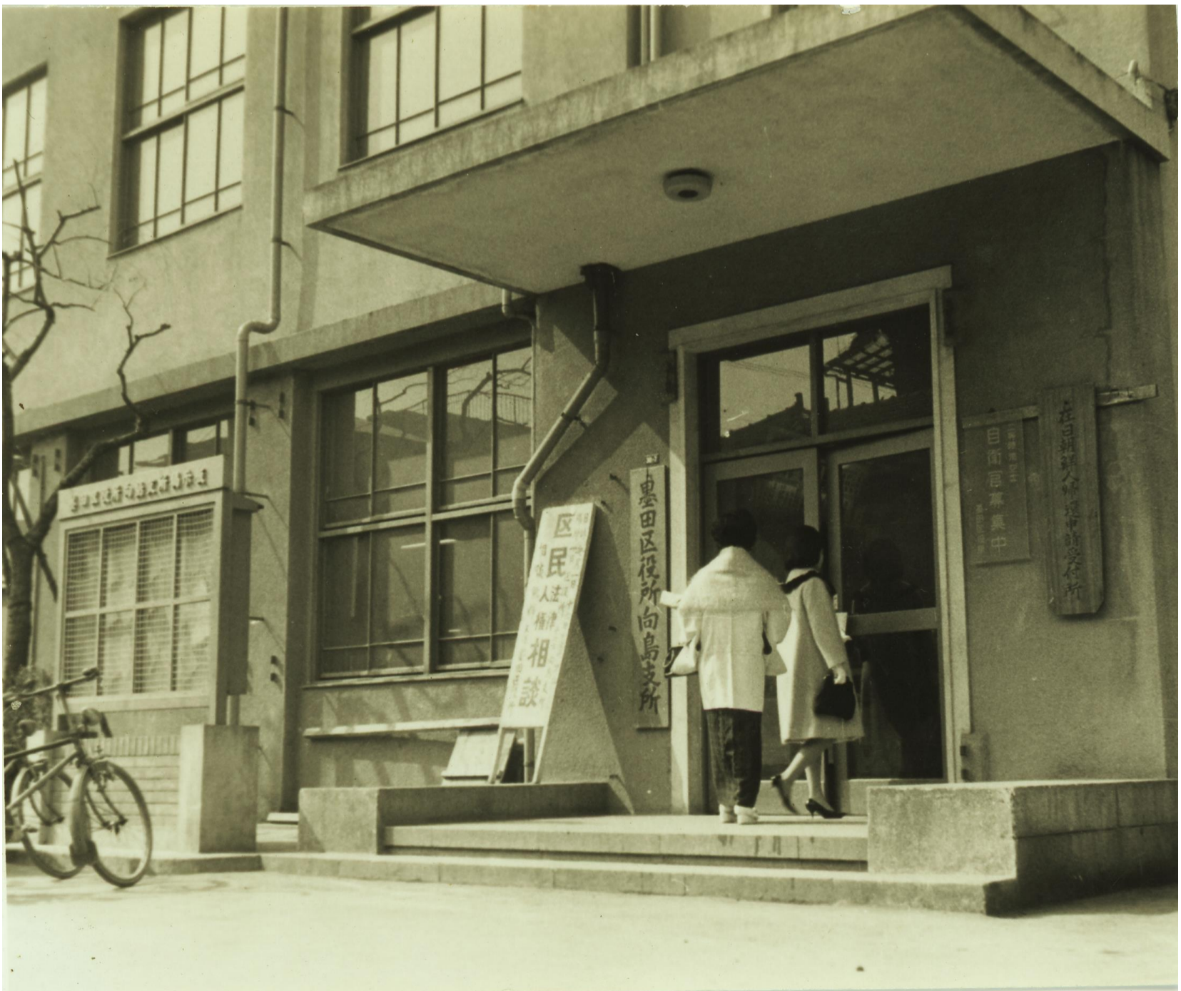
墨田区役所向島支所※25
