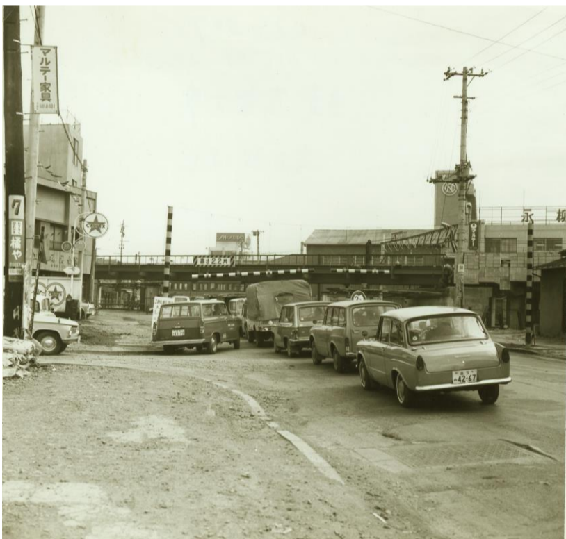
東武高架工事※5
