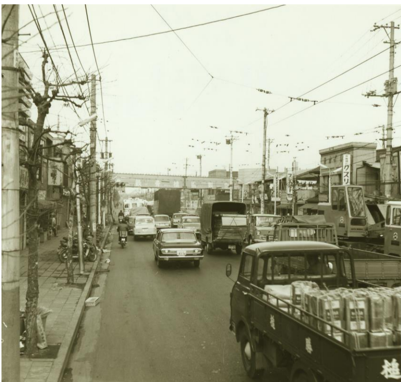
東武高架工事※7
